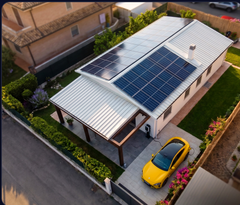
Impianto reale IBWT — fotovoltaico + accumulo, installazione nel litorale romano
